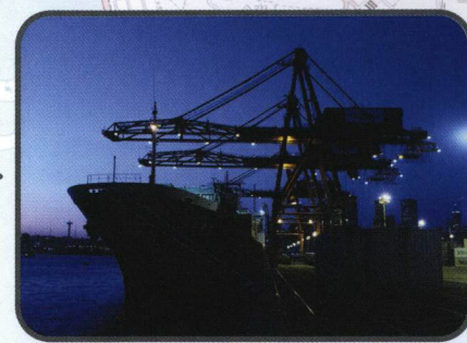
■ 대규모 부산신항 건설
